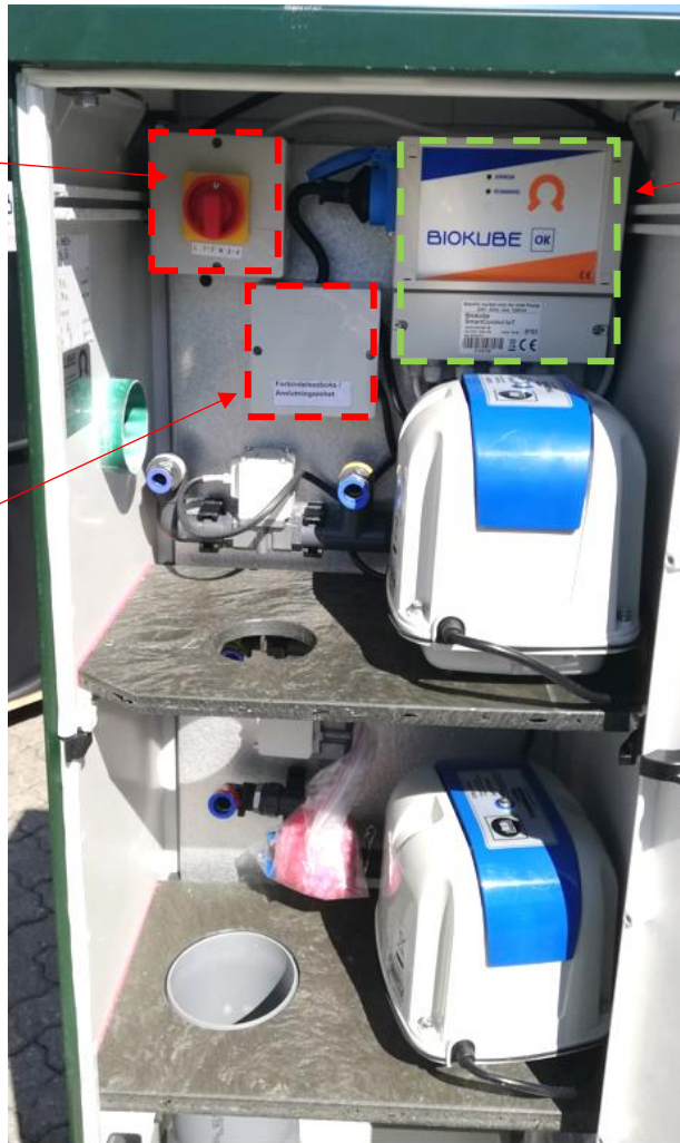
El- och kabelanslutningspunkter i det externa teknikskåpet
