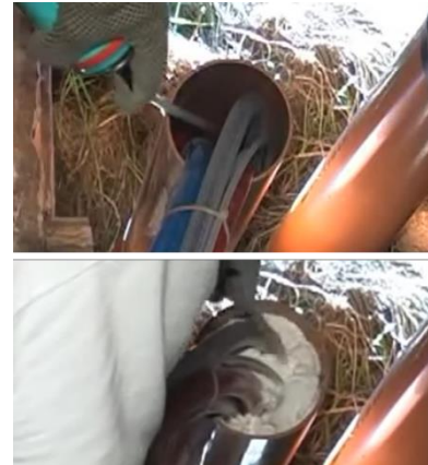
Skumning av anslutningsrör mellan reningsverk och styrskåp, för att göra dessa lufttäta
