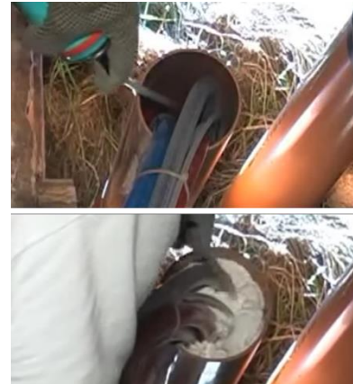
Skumning av anslutningsrör mellan reningsverk och styrskaft, för att göra dessa lufttäta
