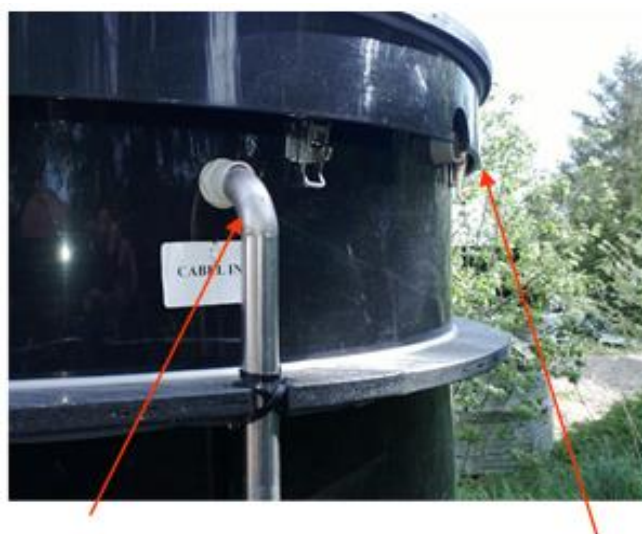
Kabelgenomföring till teknikenlådan
