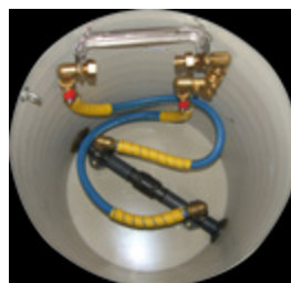
Ex. på brunn med återströmningsskydd klass 4
